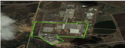
Localização: Rodovia PE-050 – Bairro Engenho Conceição, Distrito Industrial José Augusto Ferrer
