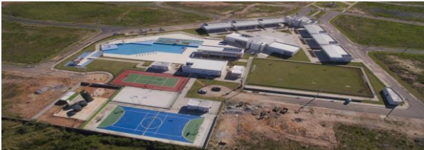
Empreendimento Solaris - Marica (RJ)
